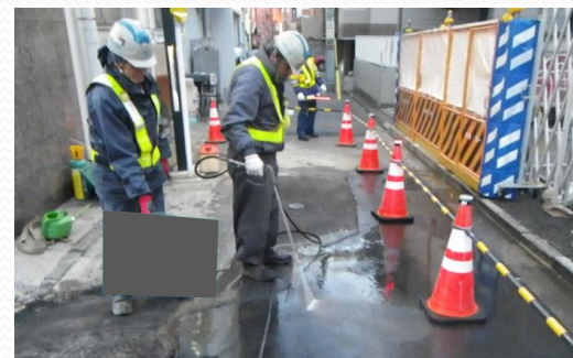
路面高圧洗浄 例
