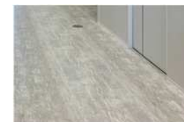
ビニル系床材の事例
