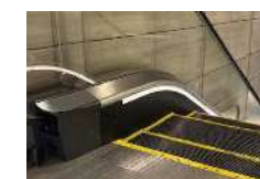
巻き込み防止を確保した事例
