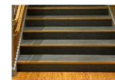
明度差を確保した事例
