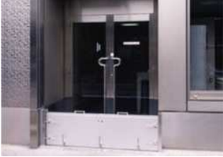
防潮板設置時の事例
