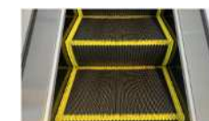
明度差を確保した事例
