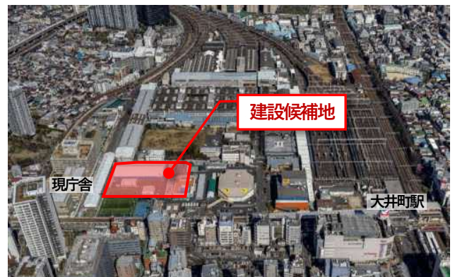
建設候補地：広町地区の現況
