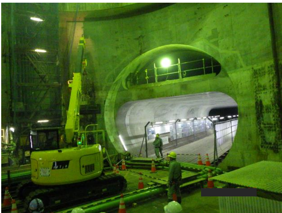
▲雨水放流管工事視察
