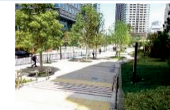
再開発事業による基盤整備(小関橋公園)
