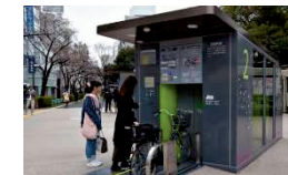
地下機械式駐輪場(大森駅水神口)
