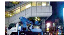
橋梁の点検状況(大森駅歩道橋)
