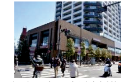
ビル低層部の生活支援施設(大井町西地区)
