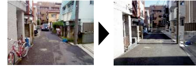
細街路拡幅整備
