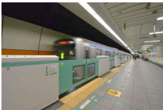
可動式ホーム柵の設置
