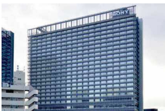
環境配慮型外装システムが採用されたビル
