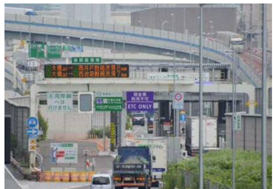
中環大井南出入口(インターチェンジ)
