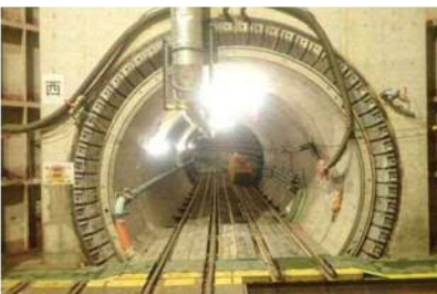
浸水被害を軽減する下水道管整備
