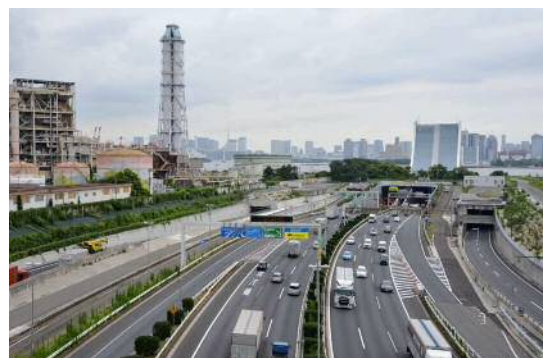
国道357号と首都高速湾岸線
