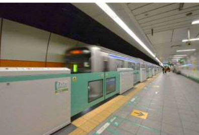
可動式ホーム柵の設置
