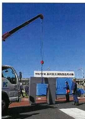
クレーン車による障害物撤去
