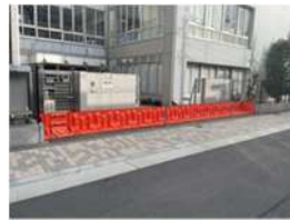
▲通用門に仮設置した止水板の様子
