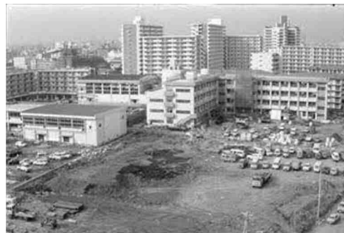
▲建設中の八潮小・中学校とコミュニティセンター(昭和58年)
