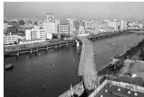
▲建設中の八潮橋
