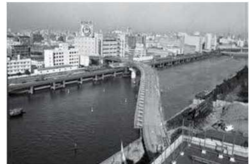
▲建設中の八潮橋
