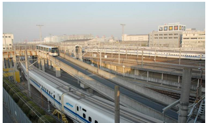
▲位於大井埠頭的新幹線車輛基地
