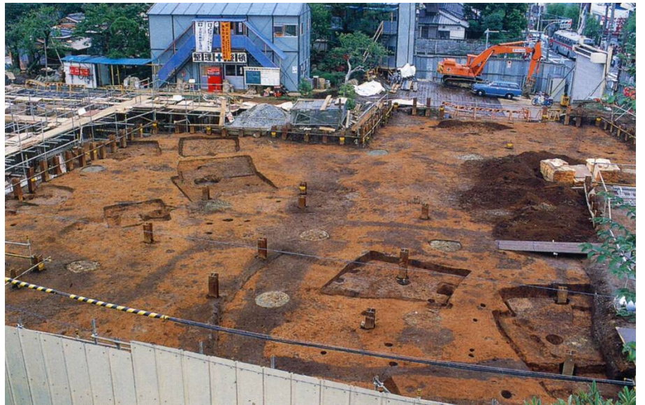
▲1983 年的挖掘情形
