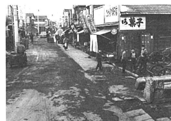
▲同地点工事終了後（昭和29年）
