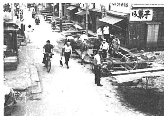
▲品川用水暗渠化工事（昭和29年）
